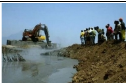
Figure 6. Construction de digues pour retenir la boue.
